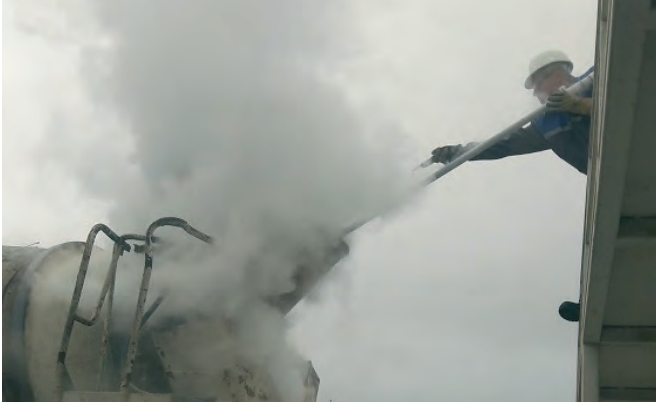
Şekil 3. Çamlica Tesisi sıvı azot uygulaması ile taze betonun soğutulması
